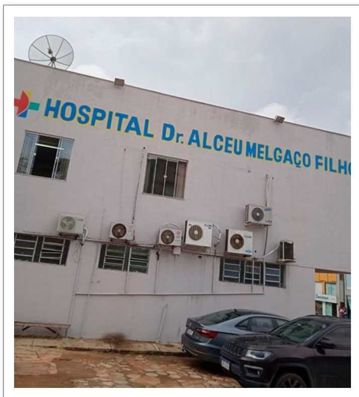
Lateral com fachada
