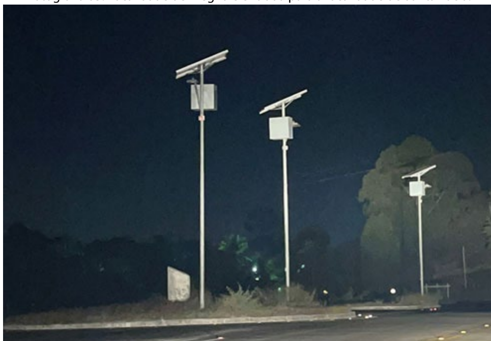
Fotografia 03: Localidade de Alegria e entrada para a localidade de Santa Lúcia.
