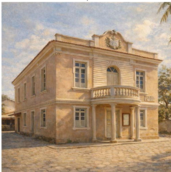
Figura 44 - Casa da Cultura Angelina Lopes, Anchieta-ES. Assentada no centro histórico do município de Anchieta-ES.
