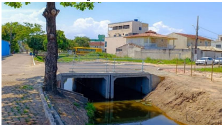
Figura 2- Galeria no Rio Una
